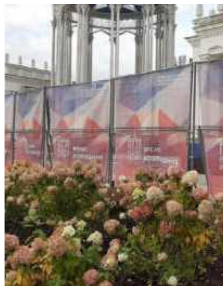
Хорошо. Стойки ограждения дополнены баннерами, выполненными в едином городском стиле, что делает забор прозрачным, не портящим городскую ткань во время проведения строительных работ
