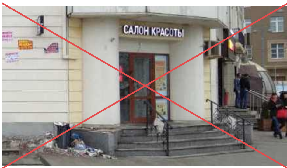
Плохо. Неравномерное свечение букв
