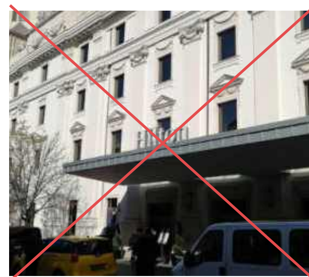
Плохо. Вывеска расположена сверху козырька
