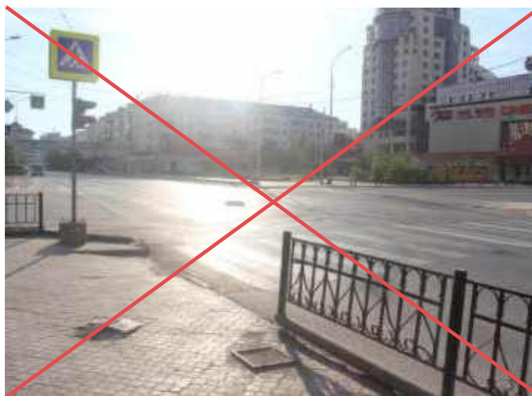
Плохо. Использование сплошных металлических ограждений на пешеходных переходах
