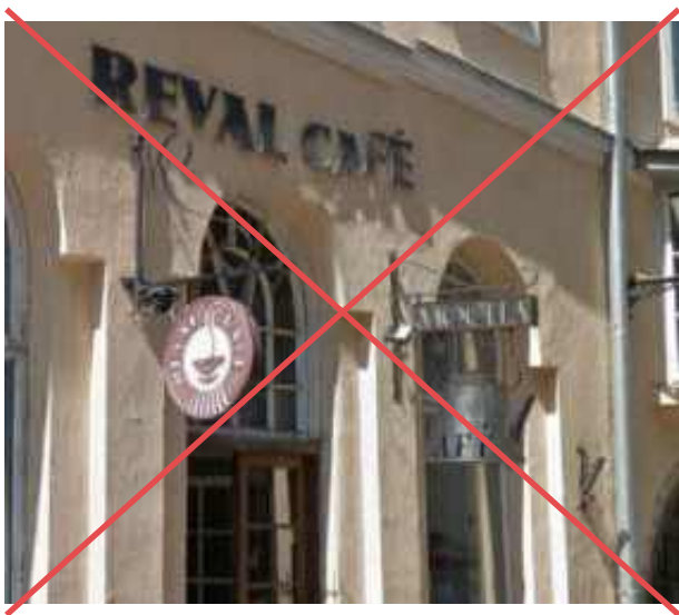
Плохо. Панель-кронштейн установлена слишком близко к настенной вывеске
