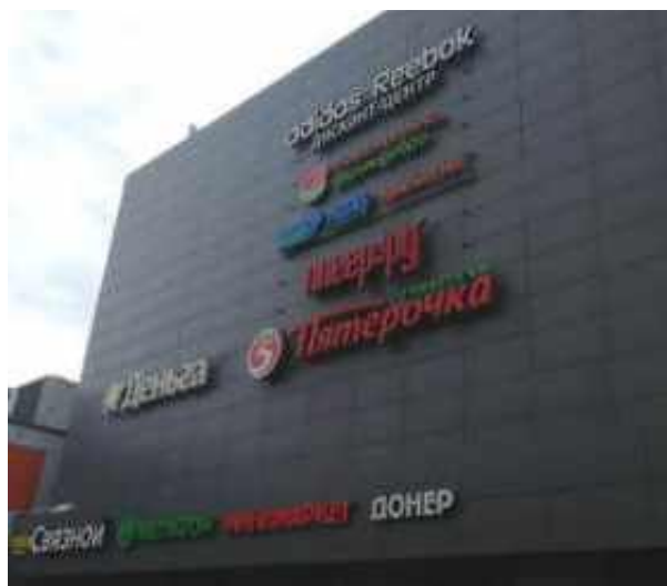
Хорошо. Вывески на фасаде современного здания торгового центра выровнены по ширине
