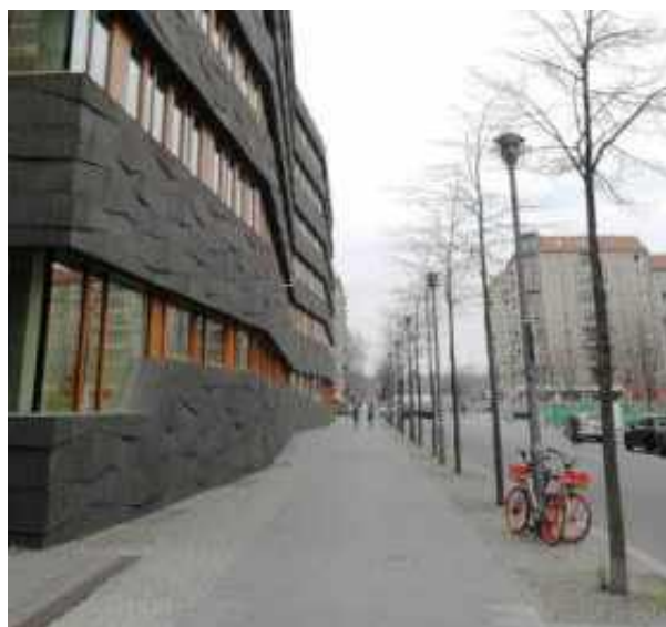
Хорошо. Использование крупноформатного мощения в месте интенсивного движения пешеходов
