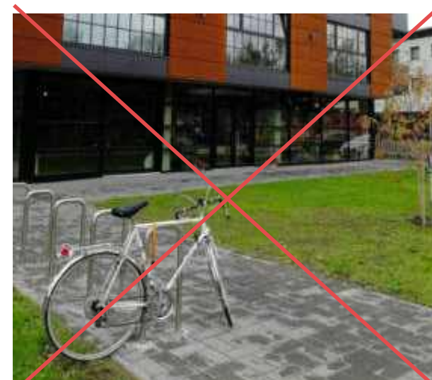
Плохо. При монтаже велопарковки не учтен размер велосипеда, поэтому его колесо попадает на газон
