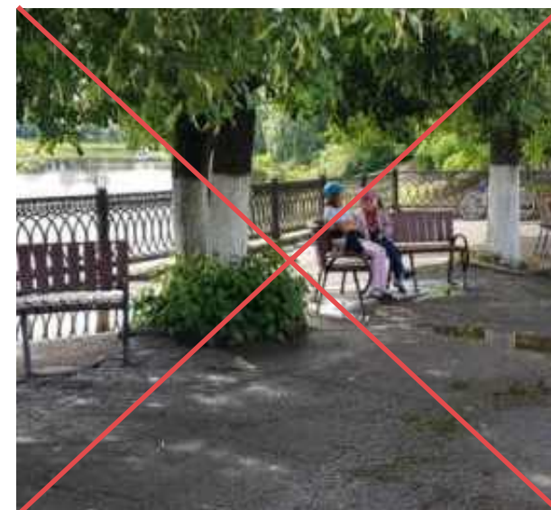
Плохо. Использование в качестве мощения тротуаров асфальта. Асфальт закупоривает почву, ведет к заплаточному ремонту, выделяет вредные испарения и быстро деформируется
