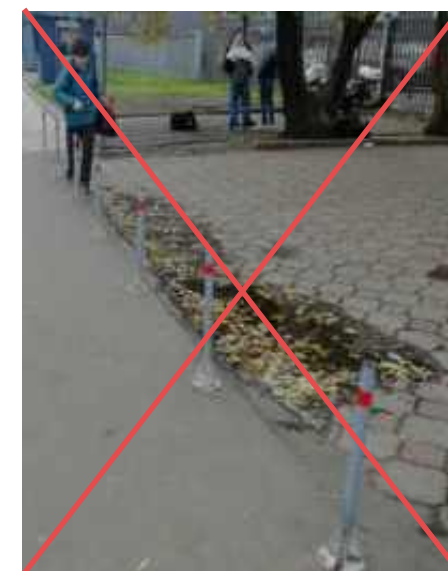
Плохо. Металлические столбики некачественно закреплены
