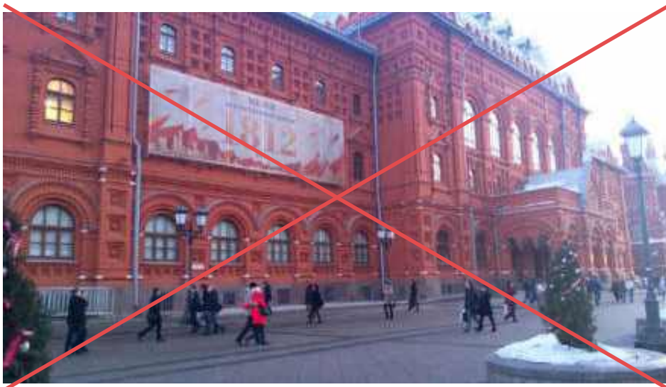
Плохо. Афишный баннер слишком крупного размера закрывает архитектуру здания
