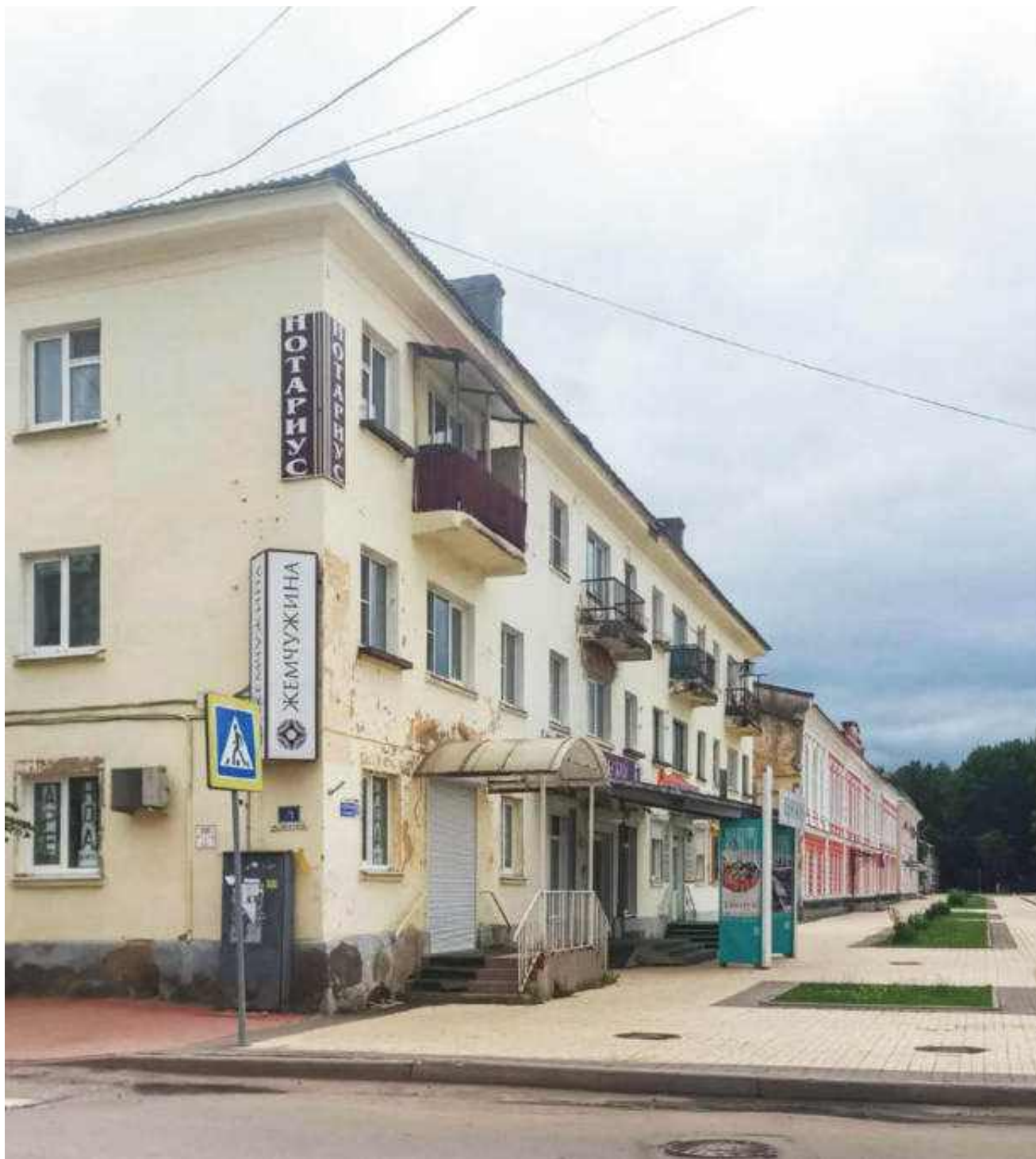
Жилые здания с коммерческими помещениями на первом этаже. Было
